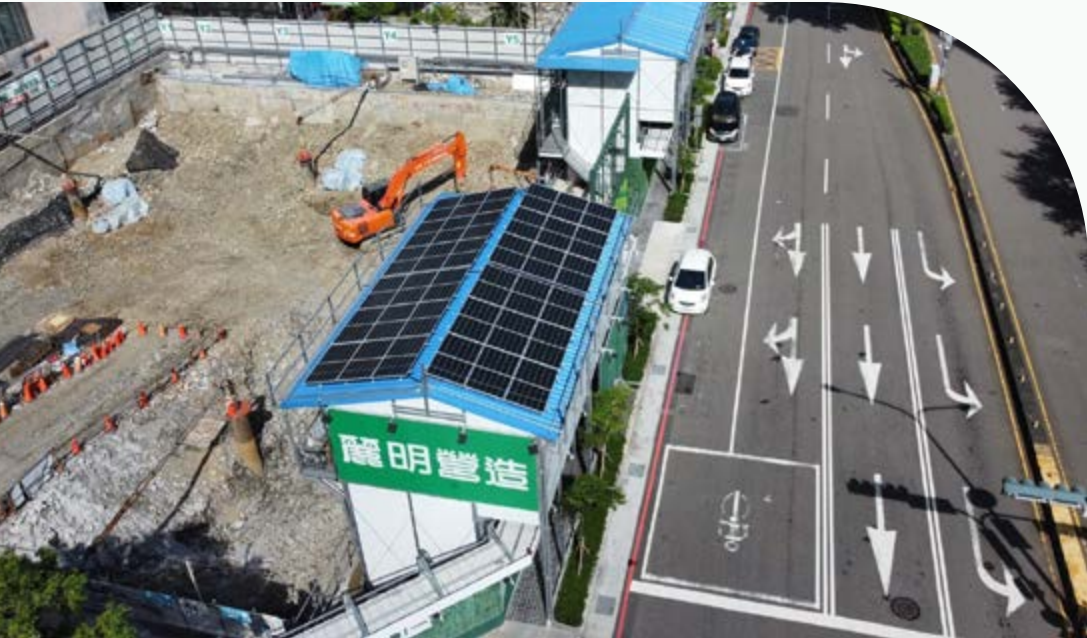
惠國郵局工地裝設太陽能板進行部分供電
