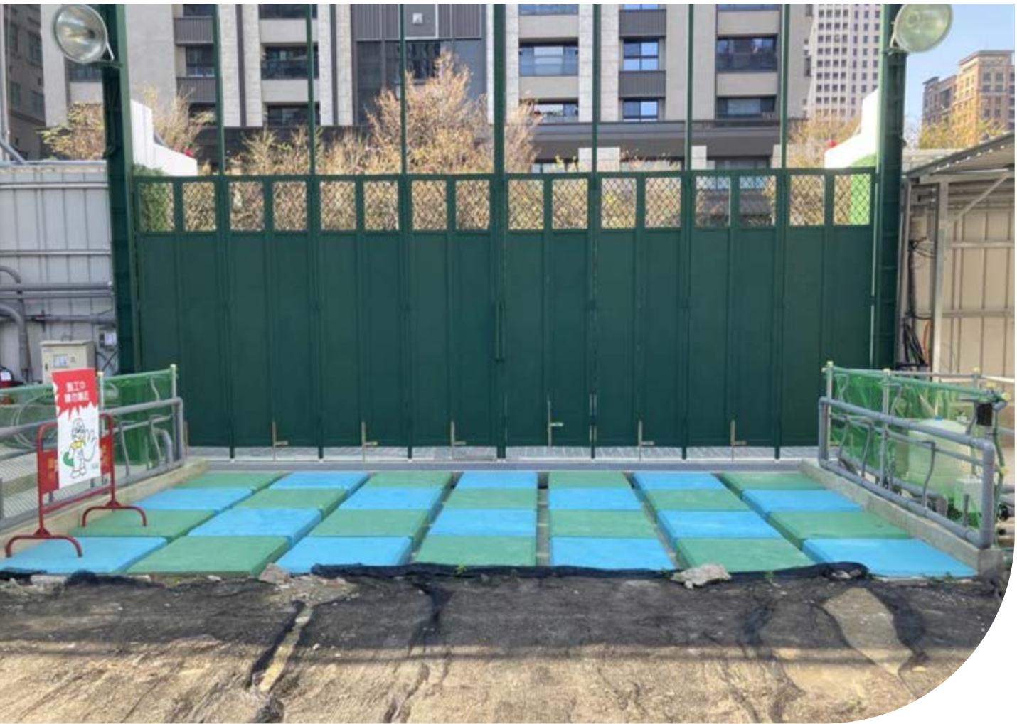
工地設置跳動路面洗車台及沉砂池，廢汙水經沉澱後始得排入排水溝
