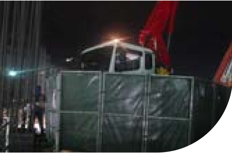
於灌漿作業泵浦車加裝隔音屏，可降低噪音污染，減少社區困擾
