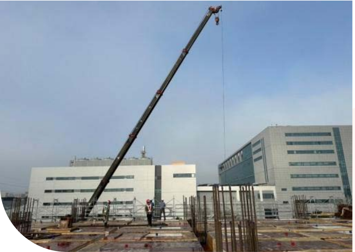
施工進度 A2 區 2FL 樑版筋吊料
